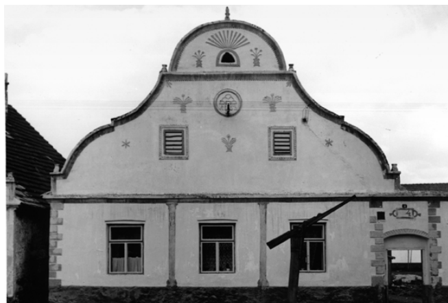
Tradiční trojdílná okna s horním větracím dílem
