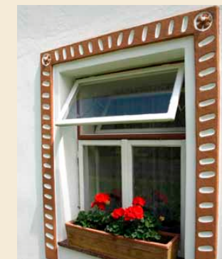
Ventilační křídlo s výklopným systémem u trojdílného okna
