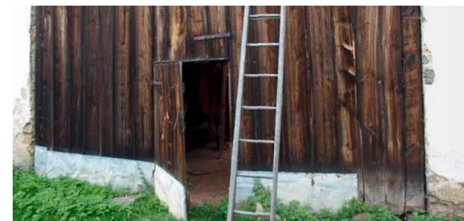
Příliš masivní obložení spodní partie vrat, která díky vlhkosti často degraduje
