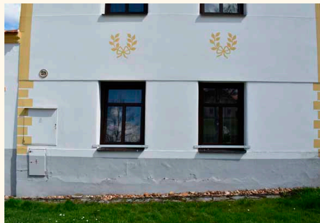
Kontextuální řešení prvků na fasádě – problematika novodobých nezbytných prvků – např. elektroskríní – tyto prvky je vhodné vyčlenit z fasád hlavních průčelí, v případě nemožnosti jiného řešení je nutné tyto prvky do hlavního průčelí zapojit kontextuálně (nezasahovat do dekorativních a plastických prvků).
