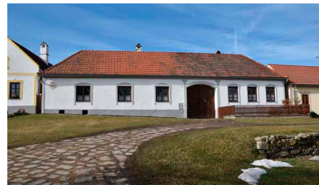
Okapově orientovaná průčelí z 2. pol. 19. století
