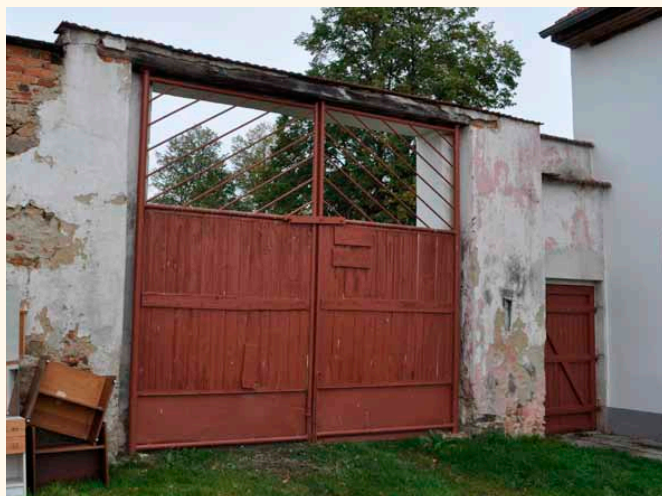
Vrata tvořená kovovou rámovou konstrukcí v kombinaci se svisle kladenými prkny ve střední části
