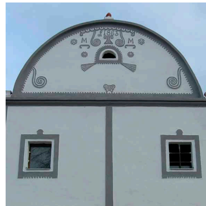
✗ Rozdílně řešená okna do půdy s mříží a se zasklením
