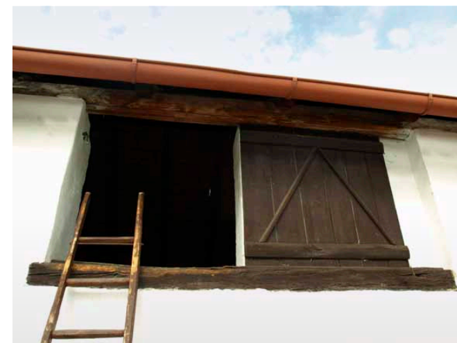
✓ Posuvná okenice tradičně užívaná k uzavírání vhozového otvoru
