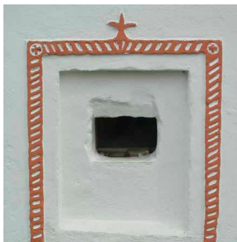
Plasticky provedená šambrána s diagonálními vrypy
