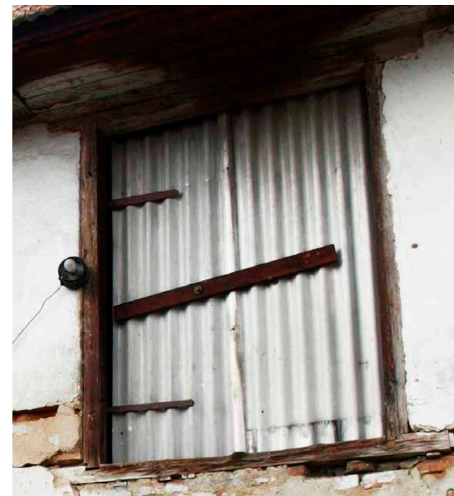
Nevhodné použití novodobé výplně z vlnitého plechu.
