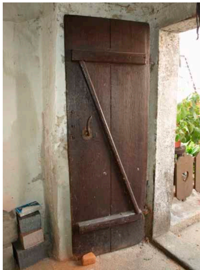
✓ Tradičně užívané svlakové dveře z širokých prken
