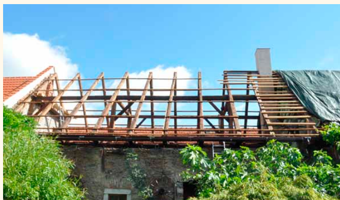
Větší rozteče vazeb mohou poukazovat na odlišný typ krytiny v minulosti.
