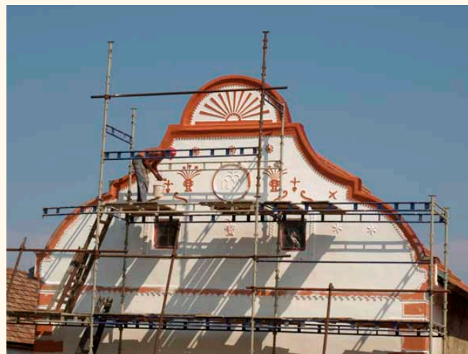
✓ Průběžná a lokální údržba fasády
