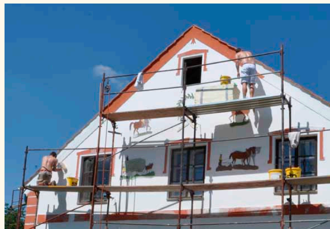
✓ Ručně nanášené omítkové vysprávký a nátěry jsou žádoucími průběžnými obnovami fasád
