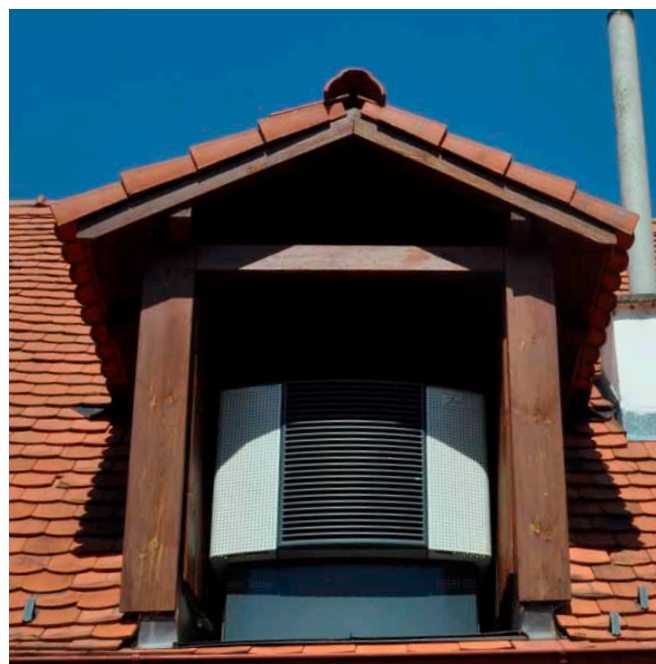
Sedlový vikýř může sloužit i jako zakrytí nevhodných cizorodých prvků, nicméně takový přístup není na sledovaném území žádoucí.
