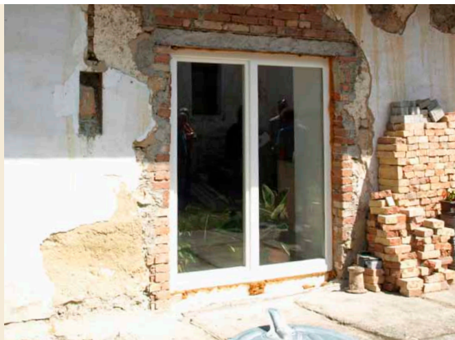
✗ Nepřípustné řešení novodobého „francouzského okna“ směřujícího do dvora usedlosti
