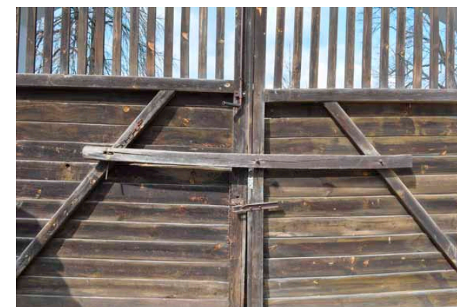
Trámková konstrukce vrat se vzpěrovou diagonálou
