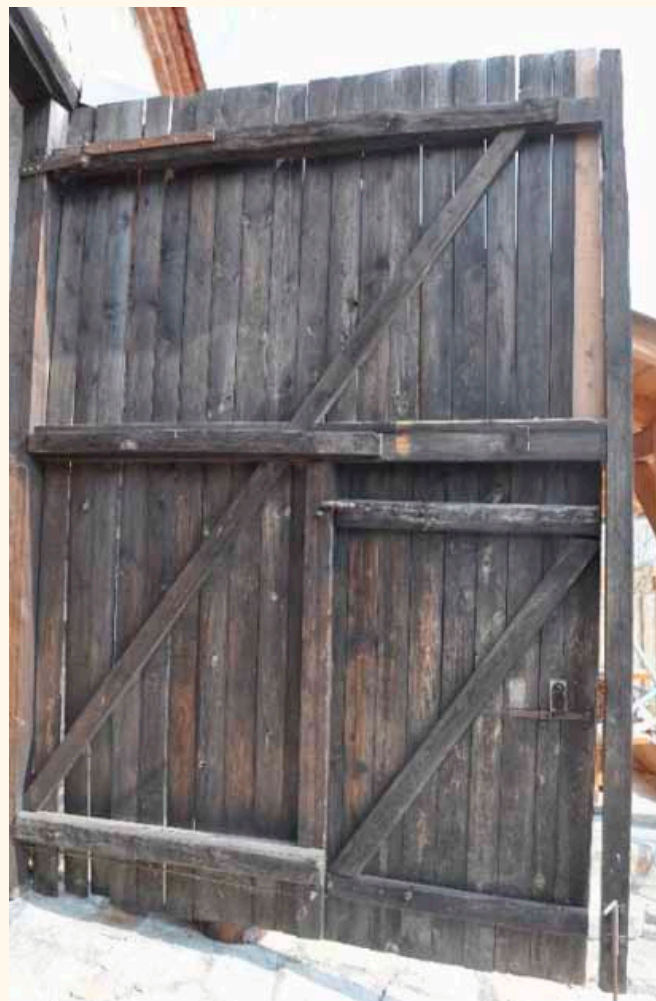
vrata s rovným nadpražím opatřena svlakovými dvířky
