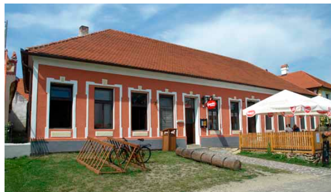
Podélný způsob orientace domu směrem k návsi
