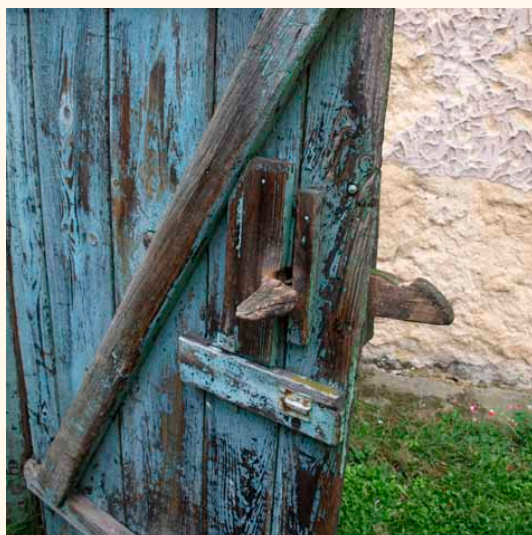
Detail dřevěné petlice starších vrátek
