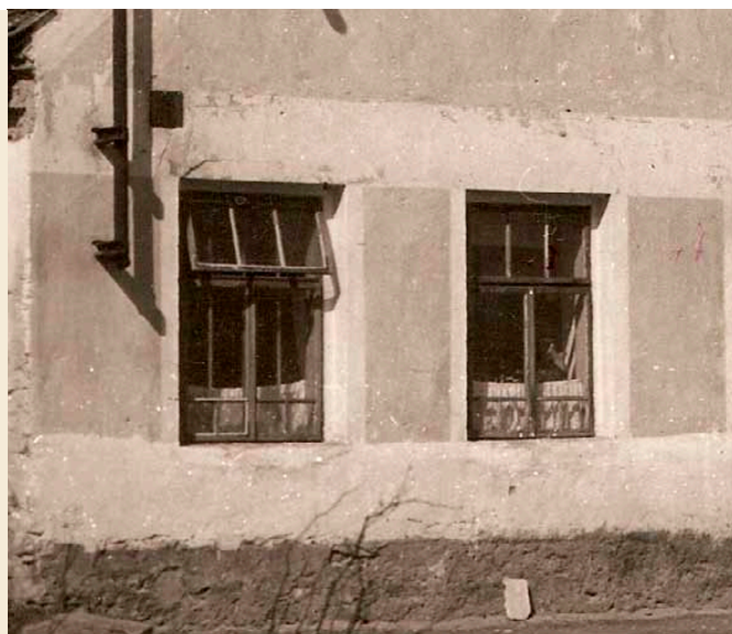
Trojdílná okna s horním větracím dílem různého členění prosklení
