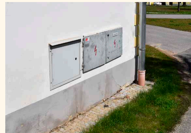
Kontextuální řešení prvků na fasádě – problematika novodobých nezbytných prvků – např. elektroskríní – tyto prvky je vhodné vyčlenit z fasád hlavních průčelí, v případě nemožnosti jiného řešení je nutné tyto prvky do hlavního průčelí zapojit kontextuálně (nezasahovat do dekorativních a plastických prvků).
