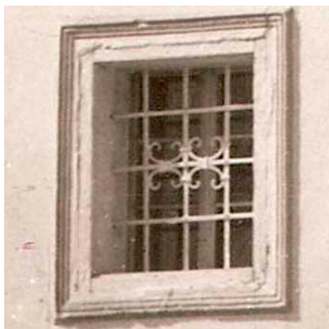
Ozdobná mříž okenního otvoru
