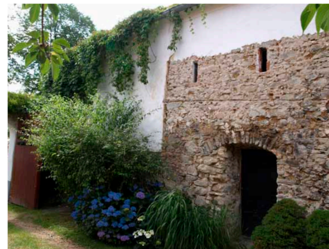
✗ Necitlivý přístup očištění omítkových vrstev, které byly kompletně sejmuty bez ohledu na jejich soudržnost
