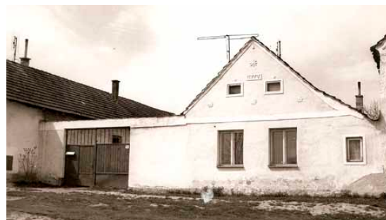
Nevhodná novodobá úprava oken a vrat v průčelí
