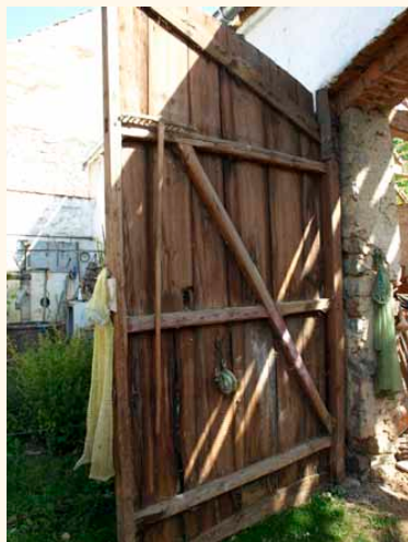
vrata s točnicovou konstrukcí
