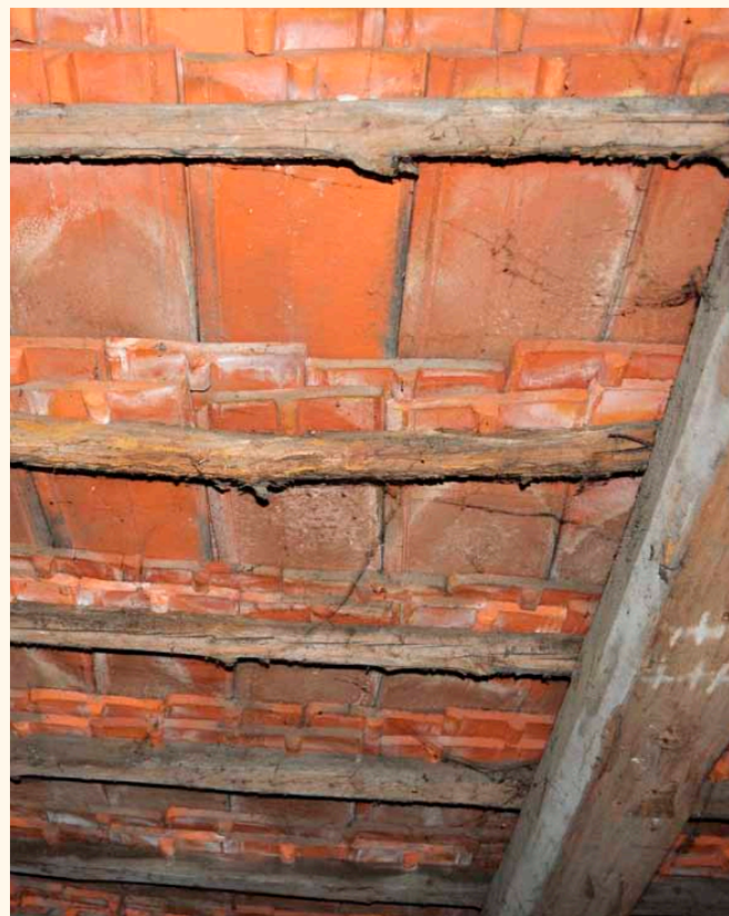
Odlišný typ krytiny užitý v minulosti lze dovozovat i z nehraněných střešních latí.
