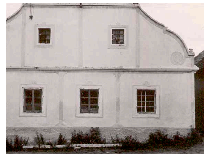
Šestitabulková okna, zamřížované okno světničky
