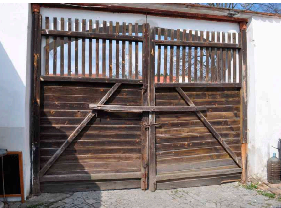
Tradičně používaná konstrukce dřevěných vrat
