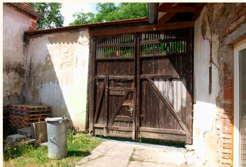
Tradiční dřevěná konstrukce vrat
