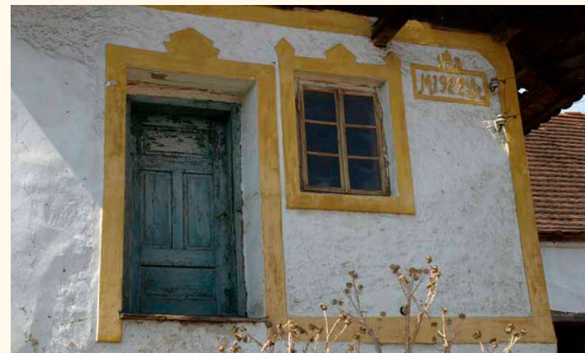
✓ Původní řešení dveří a okenní výplně čeledníku
