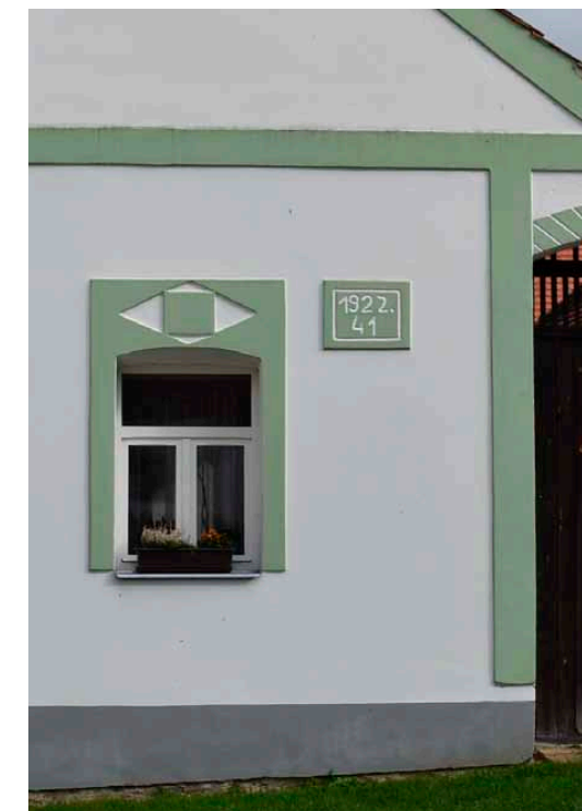
✓ Obnova původního členění okna
