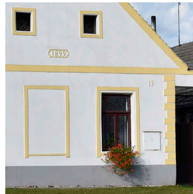
Trojdílnná okna „těčkového“ typu jsou příkladem tradičně používaných oken
