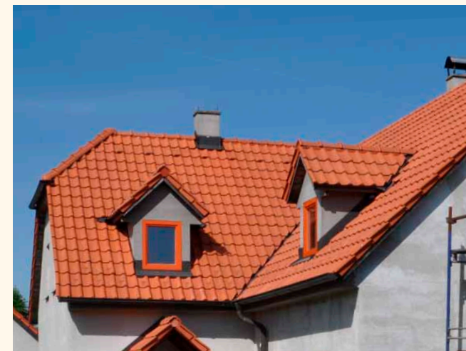
✗ betonová taška – na daném území nevhodná
