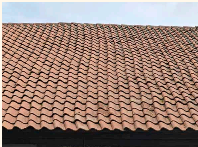
✓ méně obvyklé typy keramické tašky (na snímku typ esovka)
