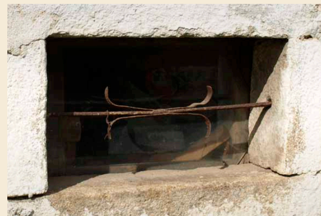
Ozdobná mříž okenního otvoru
