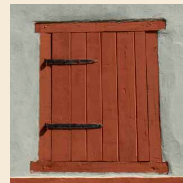
Plná jednokřídlá okenice v líci fasády
